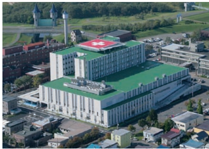
旧病院北側に建設された新本館は、RC造7階建て
