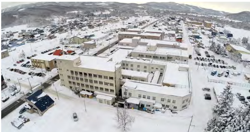
平岸病院上空から
